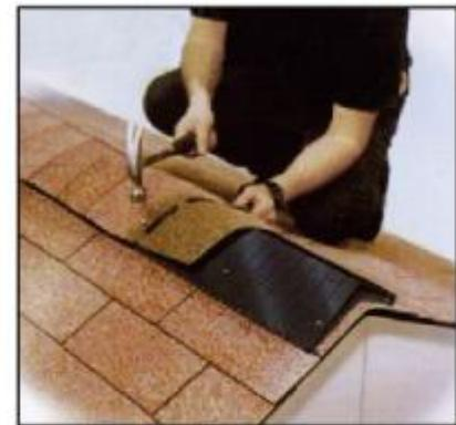
RidgeMaster можно легко устанавливать на битумную и войлочную основу, на шиферную крышу, или на крышу, выполненную из материала Tarko Inspire.
